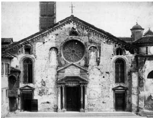
Figura 1. Facciata di Sant'Eustorgio pre-restauri.
